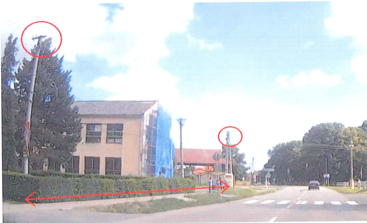
Obr. 4 Veľké rozostupy medzi svietidlami
